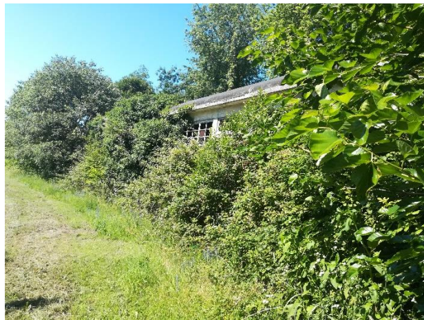
FIGURA 6 FOTO FABBRICATI B
